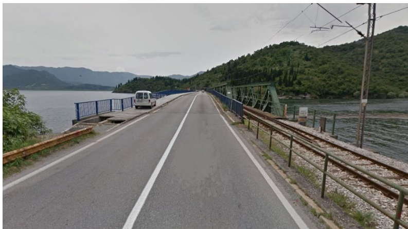
Slika br.1.11. Željezničko – drumski most preko Skadarskog jezera
