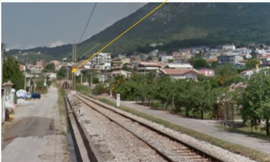
Slika br.2.16. Kuće iznad tunela u Šušnju
